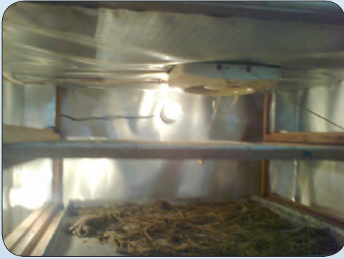
ذ: تركيب مروحة شفط لسحب الرطوبة من الفرن.
